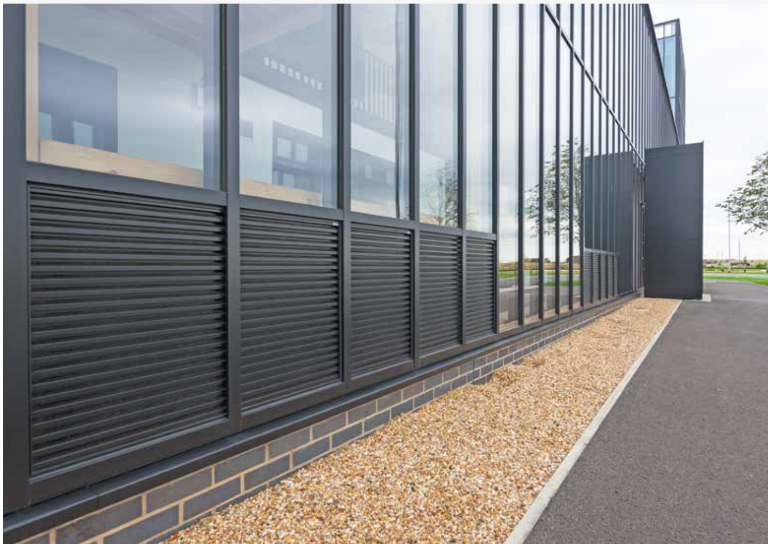
414 - Grille pour châssis
